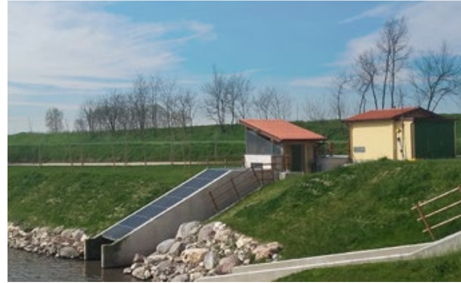
Volongo (CR) – Centrale “Volongo” – 90 kW
