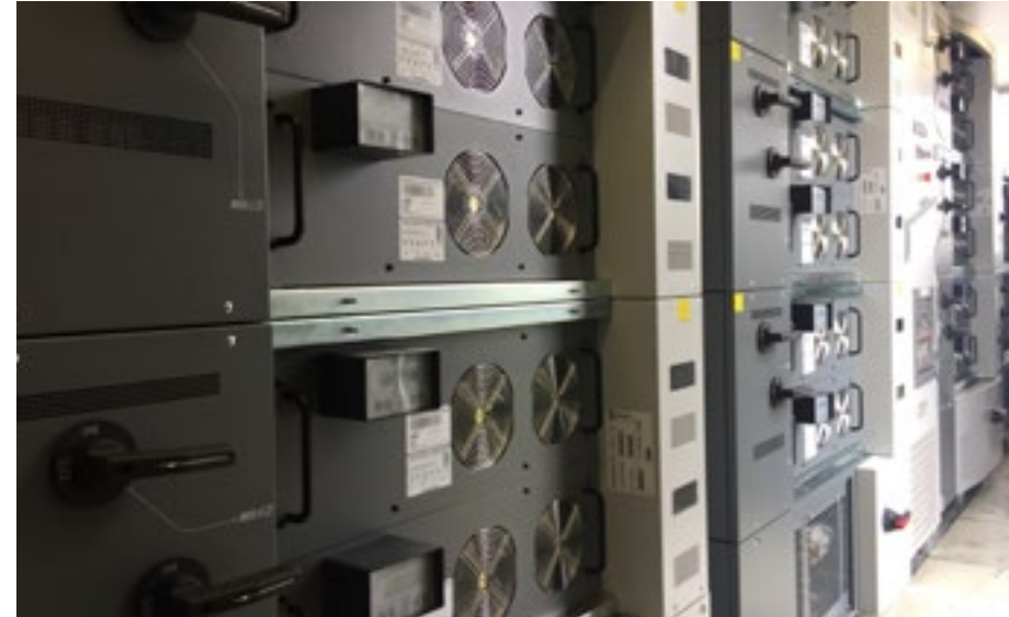
Impianto FV "PE2" - 1,1 MW
