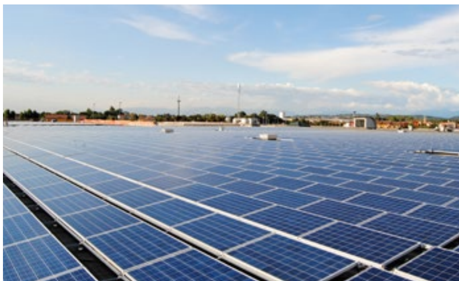
Impianto FV "Medole" - 922 kW
