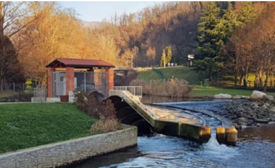
Besozzo (VA) – Centrale “Folla” – 65 kW
